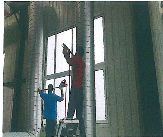
2号光解除尘器进出口
